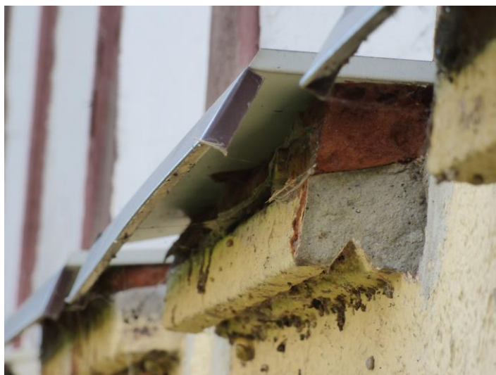
Fot. 8. Pianka izolacyjna pod parapetami analizowanego budynku.
