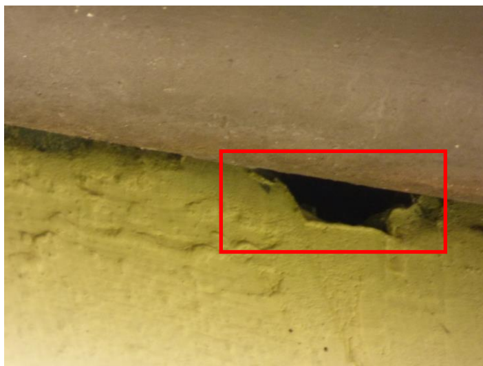
Fot. 13. Potencjalne miejsce lęgowe wróbla w ubytku elewacji pod rynną (kwadrat 5).
