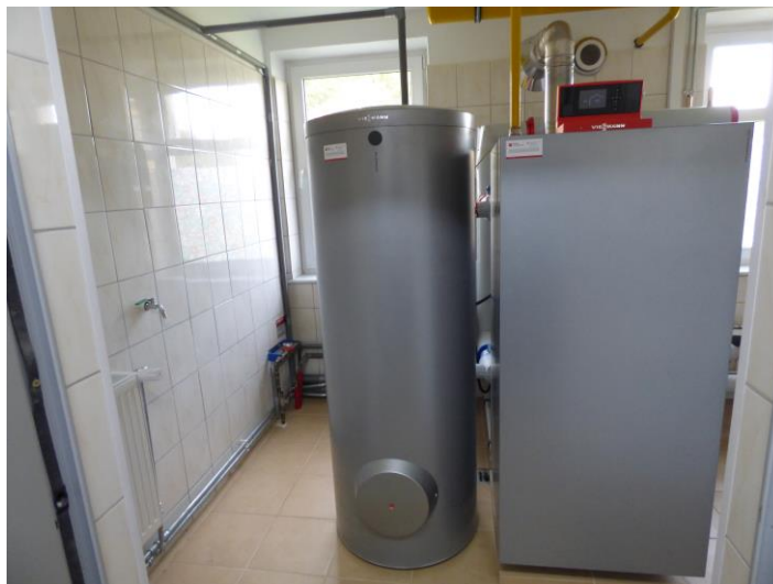
Fot. 18. Kotłownia z piecem gazowym zlokalizowana na parterze analizowanego budynku.
