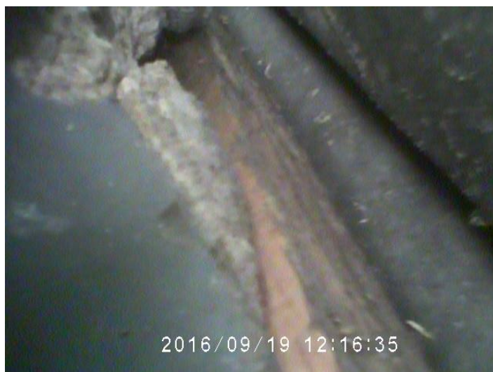
Fot. 17. Szczeliny za rynnami sprawdzone za pomocą endoskopu- brak śladów bytowania ptaków i nietoperzy.
