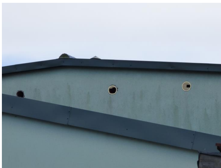
Fot. 15. Poszarpane kratki wentylacyjne w budynku znajdującym się w pobliżu Zarządu Dróg Powiatowych w Białogardzie.
